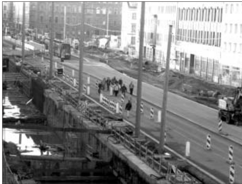
Leipzig und seine Straßen-Baustellen ... aber es kann nur noch besser werden.
