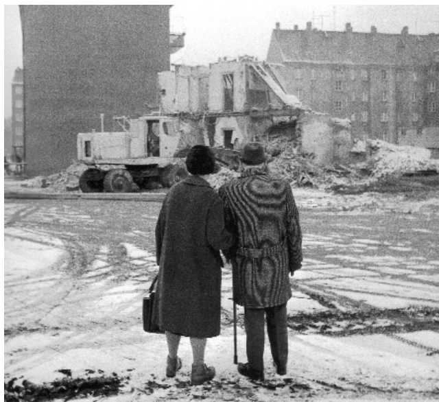
Abriß Wohnhaus, Wolfgang-Heinze-Straße, 1972
