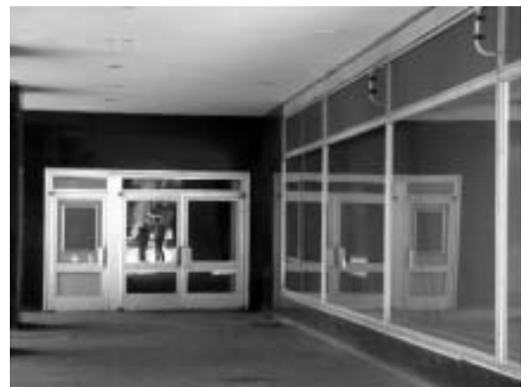
Tausende strömten täglich durch diese Eingänge. Die „Blechbüchse“ bleibt im neuen Projekt erhalten.
