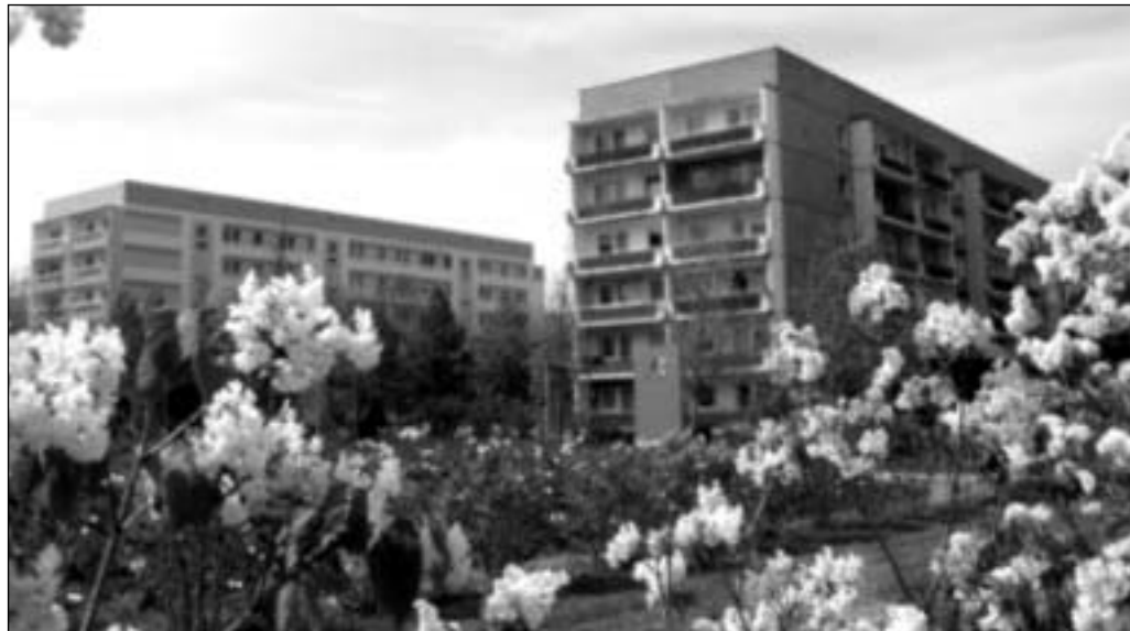
Grünau im Wandel der Zeiten ... Die Grundfläche des abgerissenen Punkthochhauses Am Schwalbennest Nr. 4 wurde jetzt etwa 1,30 Meter aufgewölbt, bepflanzt und damit räumlich von ihrer Umgebung abgehoben.
