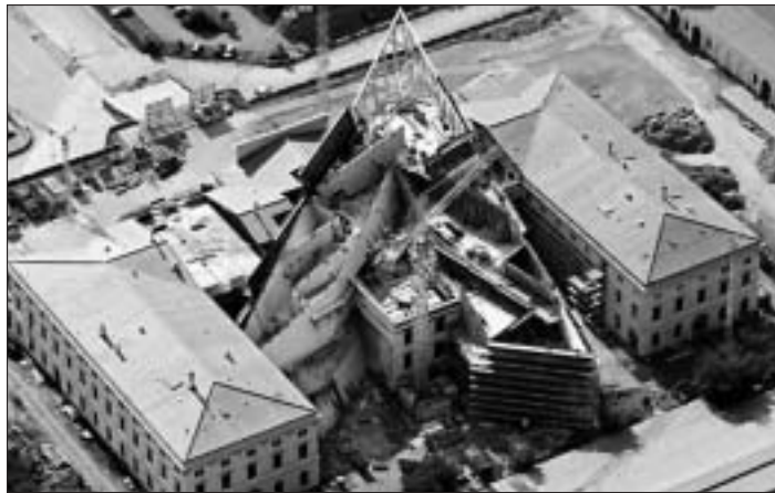
Ein Keil durchschlägt den historischen Bestand: Eine große Herausforderung für das Bauunternehmen und die Schalungs- und Gerüstspezialisten.
