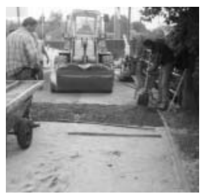
1998 wurde der Hauptweg Prießnitzstraße 1 gepflastert. Viele Gartenfreunde halfen dabei.
