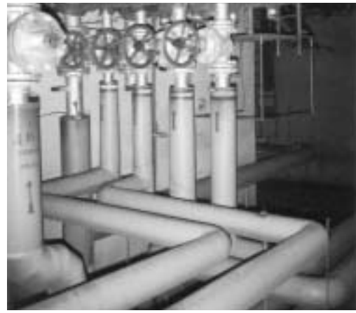
Lange Leitungen der alten Wärmeumformstation. Längst abgebaut und durch menschliche Wärme ersetzt.
