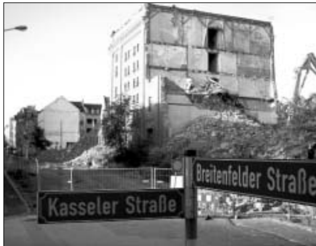
Und wieder tobt die Abrissbirne: Ein schmerzlicher Abschied nicht nur für die ehemaligen Brauereimitarbeiter des VEB Sachsenbräu, denn hier in den Büros sind auch die ersten Ausgaben von LEIPZIGS NEUE entstanden.
