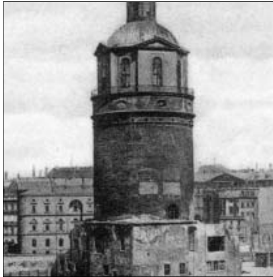
Nach Abriss der Pleißenburg, unmittelbar vor Beginn des Rathaus-Neubaus
